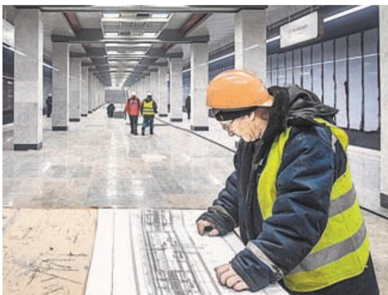
Строительство в Новой Москве станции метро «Коммунарка» на Сокольнической линии. Открытие запланировано на май 2019 г.
