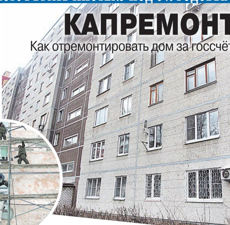
Межпанельные швы теперь герметичны и утеплены, а в подъездах установлены ПВХ-окна — всё это значительно сократило потери тепла.
