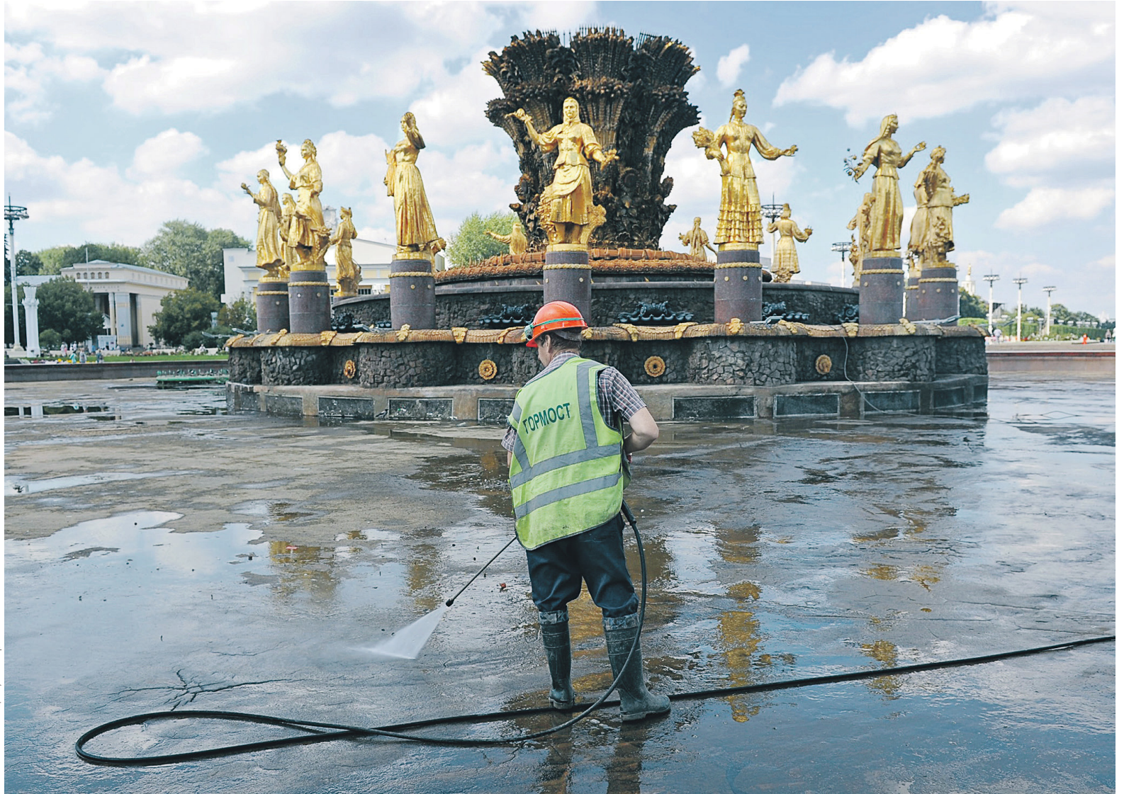
При реставрации фонтаны на ВДНХ очистят, некоторые их элементы будут отлиты заново. На фото: фонтан «Дружба народов»
