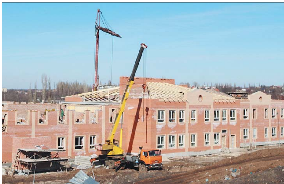
Новый подрядчик обещает закончить строительство детского сада на Мечникова в срок.
