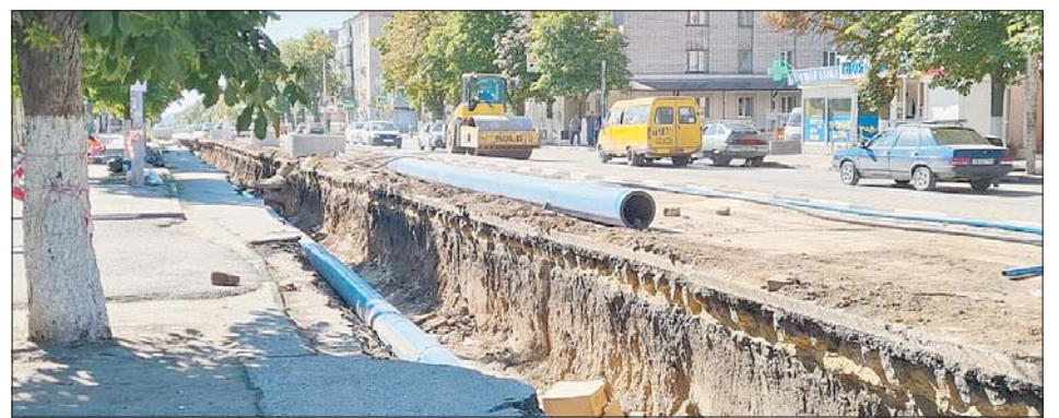
Реконструкция водовода на главной городской улице затянулась почти на год.
