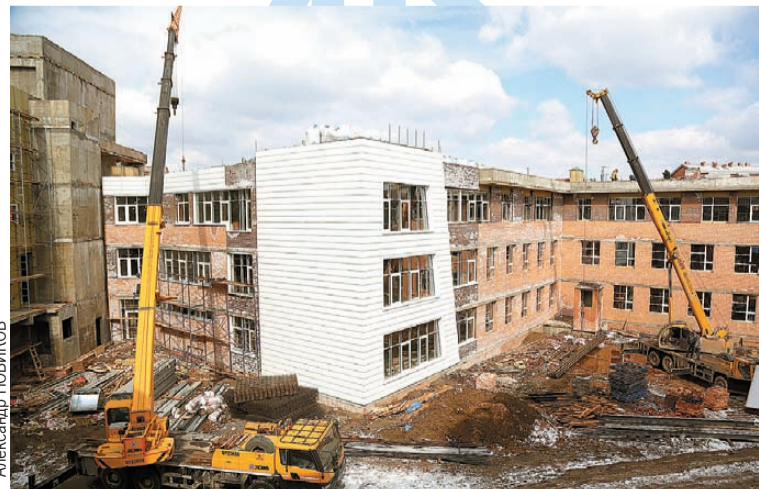
В этом году в Академгородке завершится строительство школы № 19.
