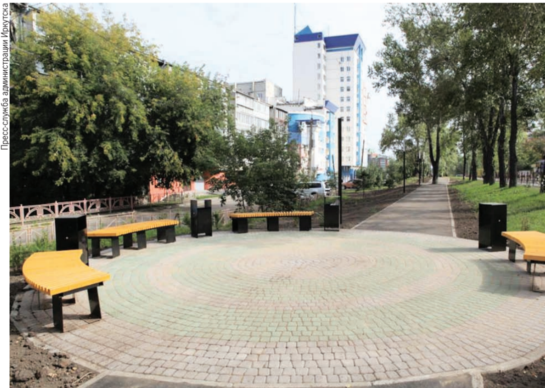
Качество работ контролируют каждый день.
