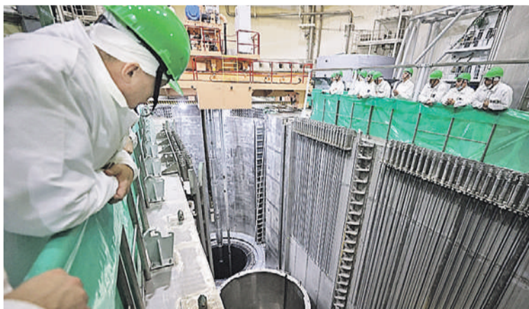
Загрузка ядерного топлива в реактор второго энергоблока - зрелище увлекательное.
