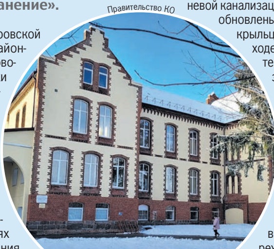
Благоустройство территории включало в себя земляные работы и укладку плитки.
