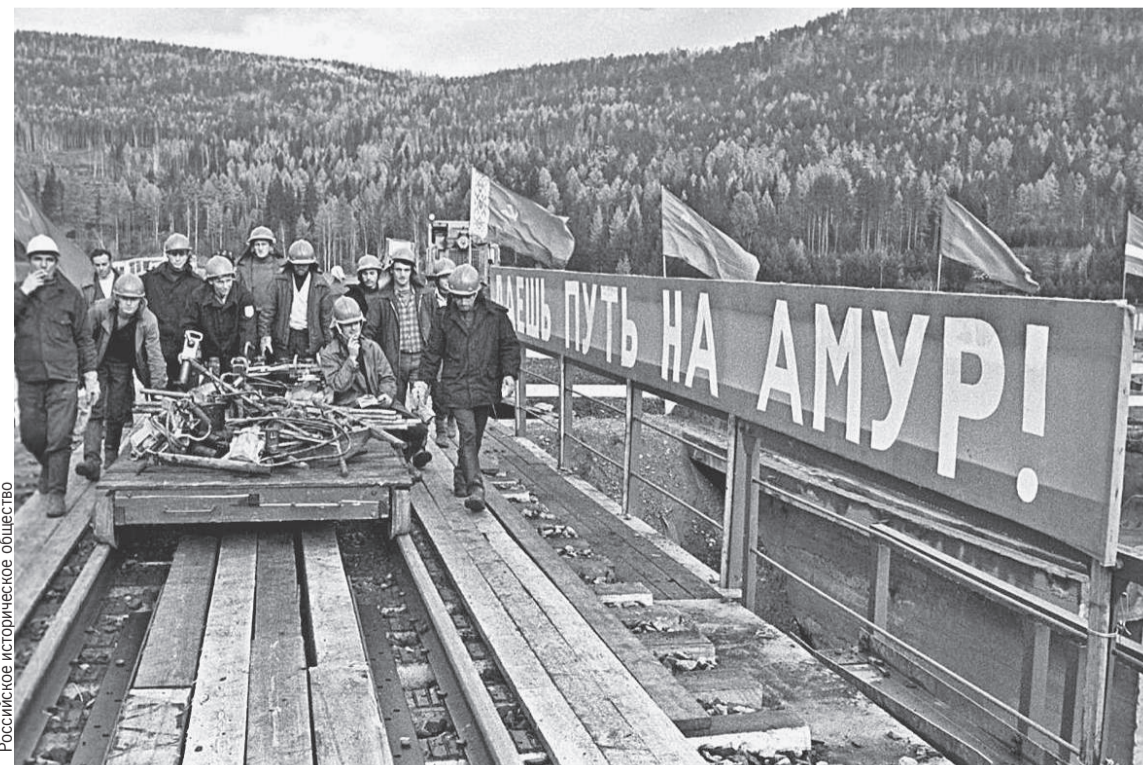
50 лет назад, в основные годы строительства БАМа, было проложено около 3 тысяч км пути.
