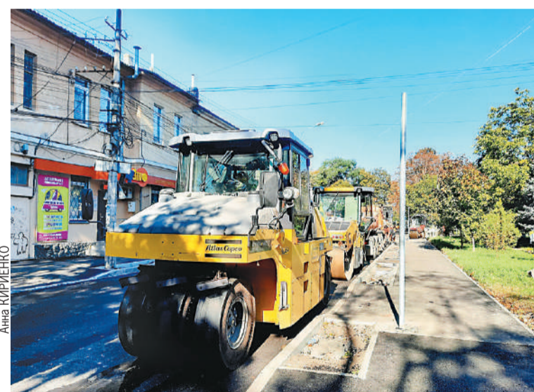
За первое полугодие отремонтировали 31 улицу.
