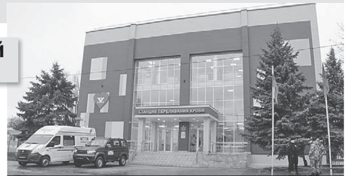
Строительство нового перинатального центра в Донецке.
