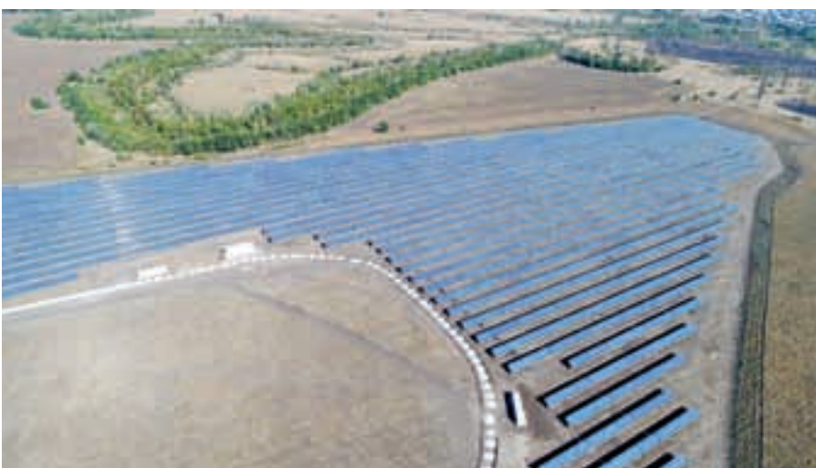
В Саратовской области уже действует несколько солнечных электростанций, первая была построена в Пугачевском районе.
