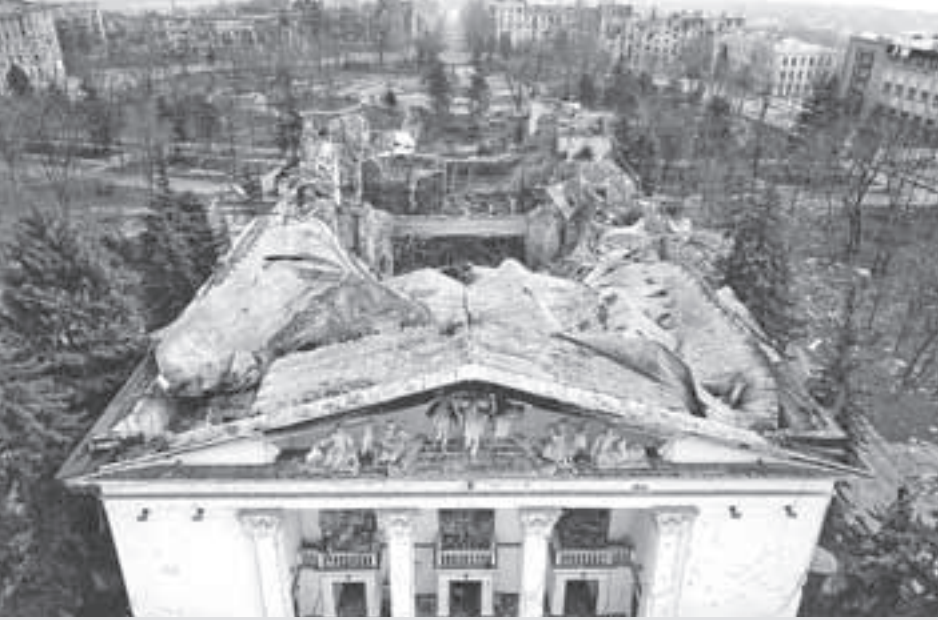
У Мариупольского драмтеатра после подрыва изнутри в 2022-м сложилась крыша, но стены устояли. Люди в подвале остались живы. Теперь Украина хочет повторить свой «трюк» - уже в детском саду или в больнице.
