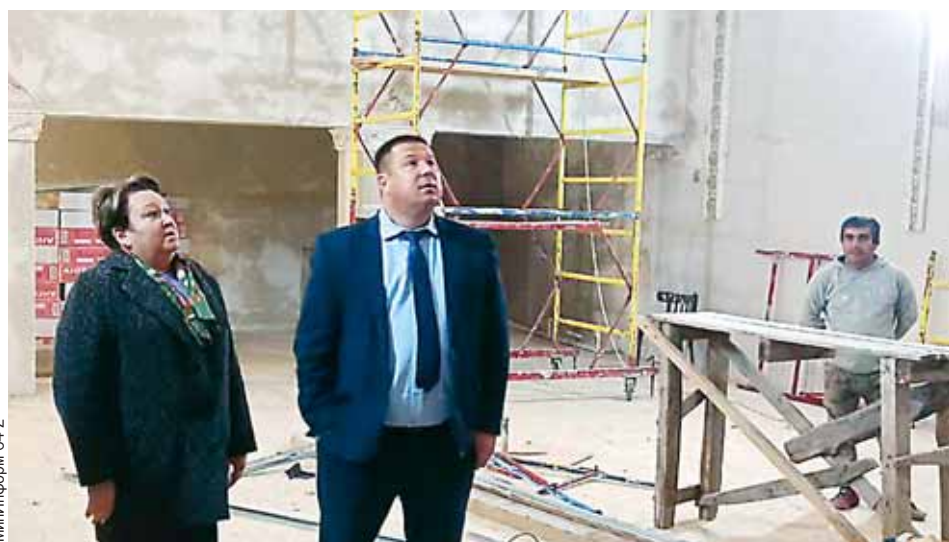
В районе ведутся реконструкция стадиона имени Н.А. Кравченко, строительство станции по борьбе с болезнями животных и капремонт ДК в поселке Загородный.
