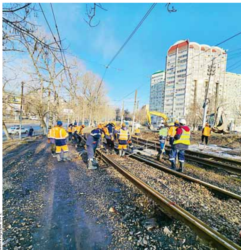
Реконструкция трамвайного маршрута № 3 пройдет в несколько этапов.
