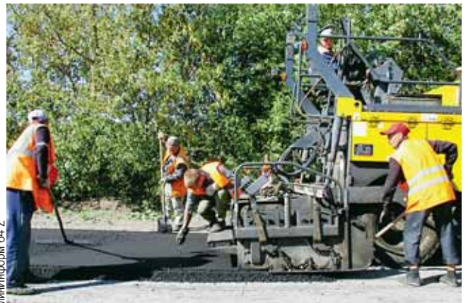
Объекты для ремонта выбирают сами жители сельских поселений.
