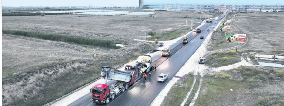
Ремонтные работы на автодороге Манас - Сергокала - Первомайское в Карабудахкентском районе.
