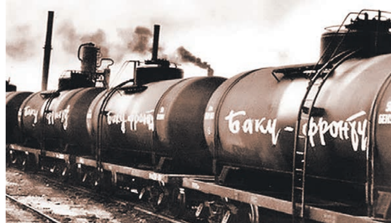
Вначале основным доставщиком топлива на фронт была железная дорога. Однако она сильно проигрывала в эффективности трубопроводам.
