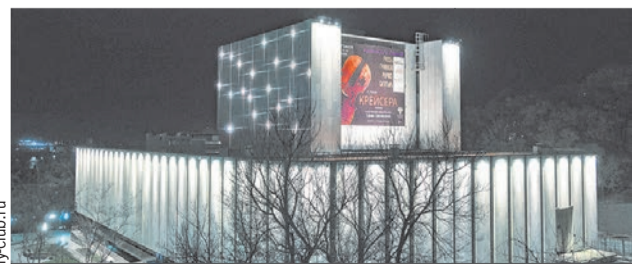
Перед саммитом у театра отремонтировали фасад.
