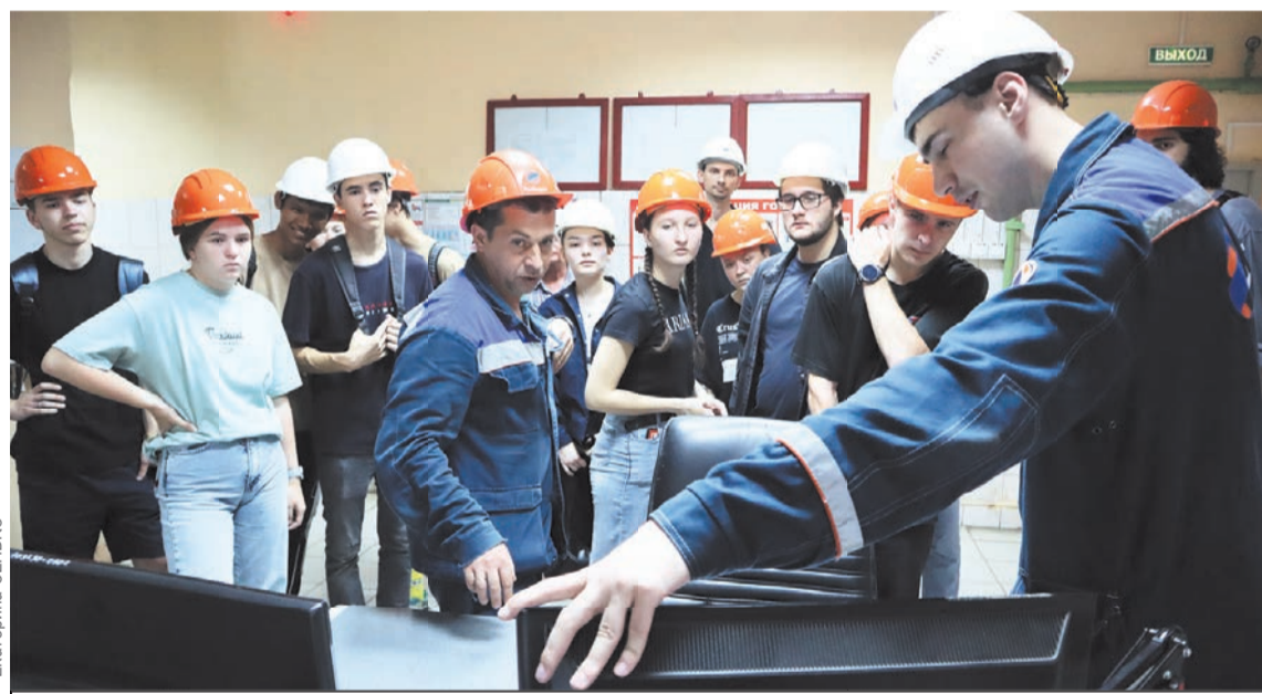
«Сердце» ВТЭЦ-1 - щит управления.
