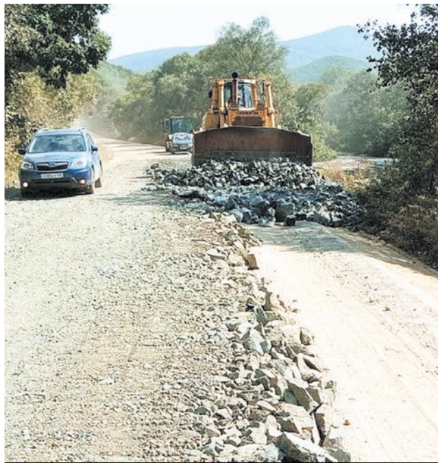
Специалисты восстанавливают поврежденные дороги.
