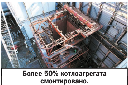
Второй этап реконструкции предусматривает замену турбины и монтаж нового котла.
