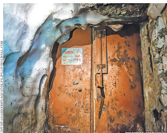
В этой камере с 1962 по 1990 год хранилось сливочное масло. Сейчас вход в нее промерз настолько, что с трудом открывается лишь одна створка.
