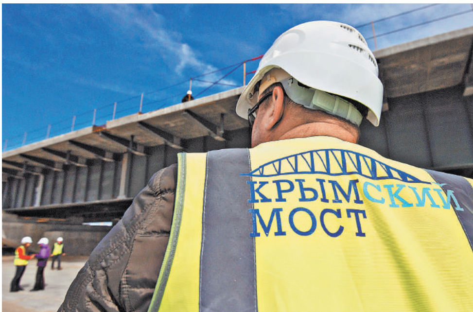
Устроителей Крымского моста есть и свой песенный хит: «Я забиваю сваю, я сваю забиваю...»
