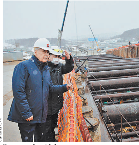
Мэр столицы Сергей Собянин осматривает ход строительства новой станции «Пыхтино».
