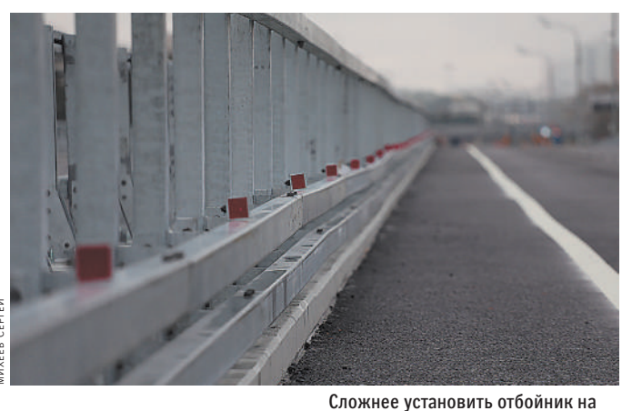
Сложнее установить отбойник на узкой дороге — требуется дополнительная полоса.
