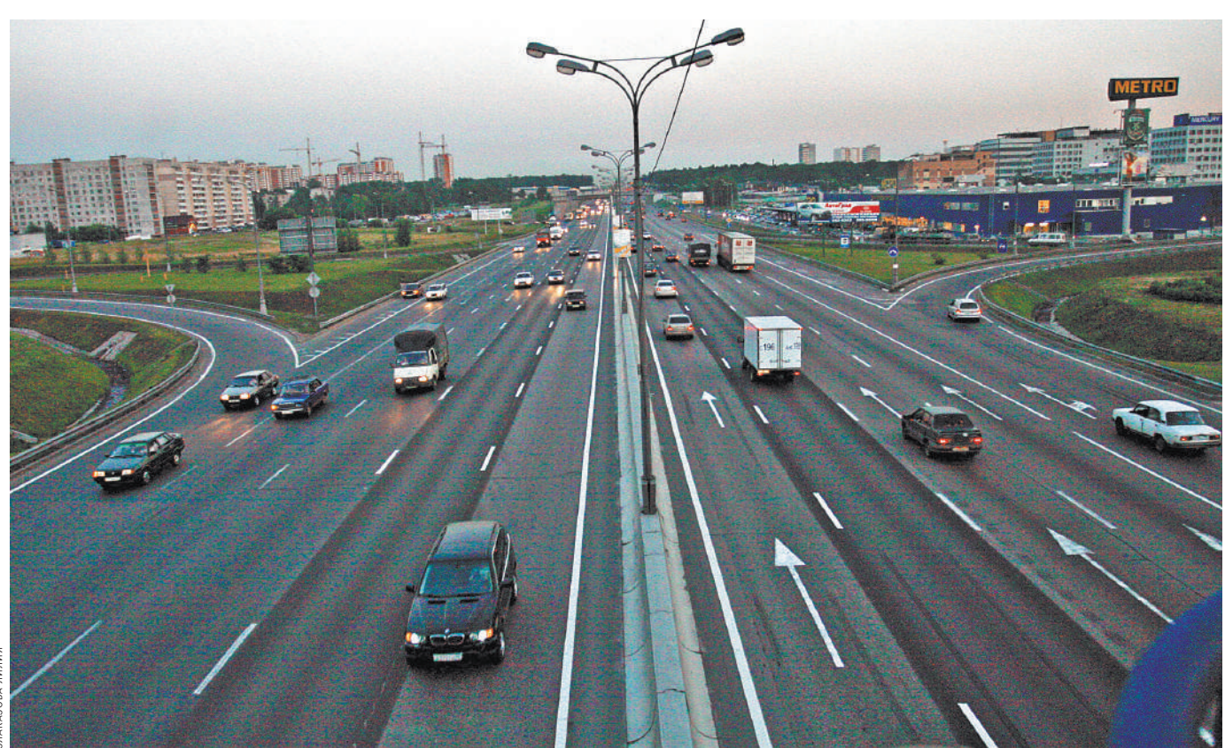
Установить бетонный отбойник на многополосной дороге — не проблема.
