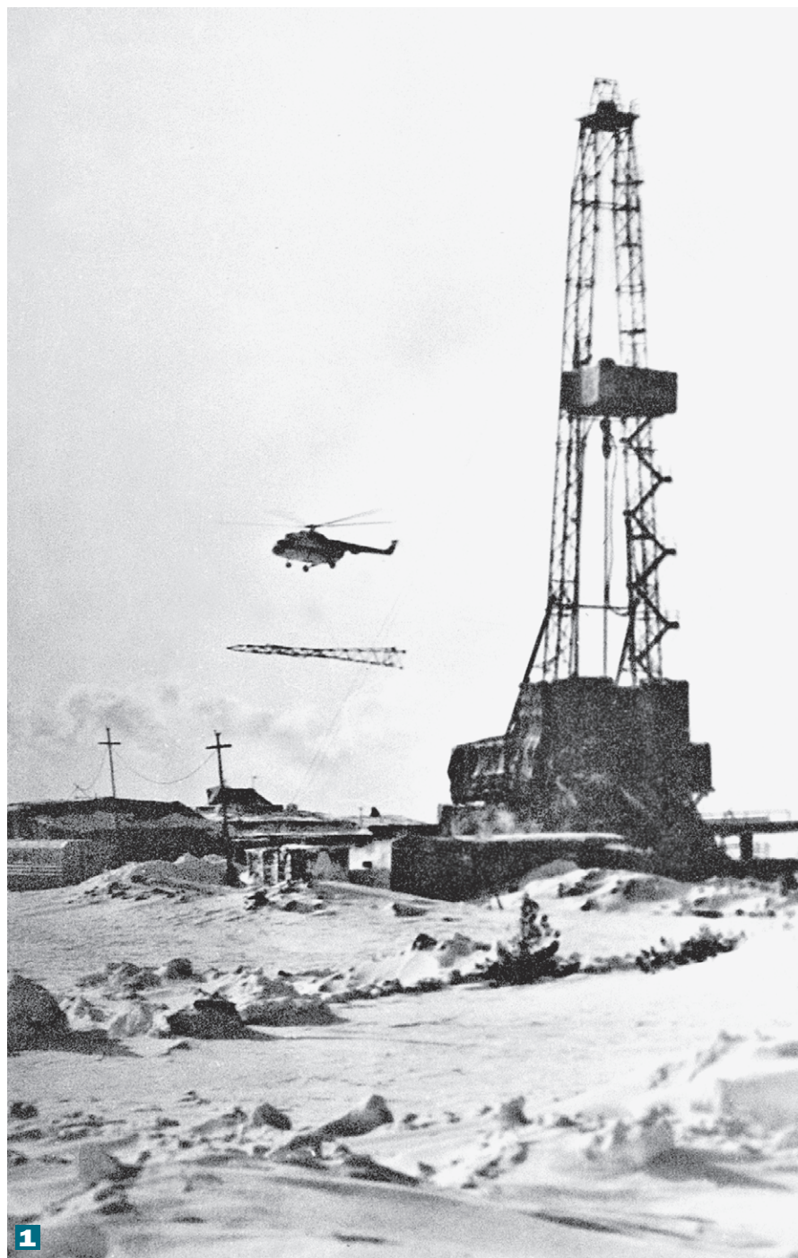
1 Вышки на место монтажа доставляли по воздуху.
