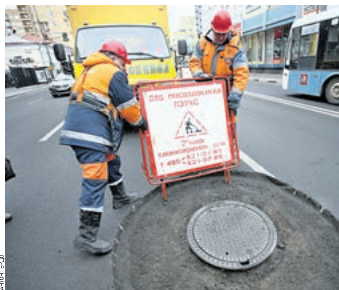
Вчера 10:47 Дорожные рабочие огораживают яму вокруг канализационного люка на проезжей части Таганской улицы
