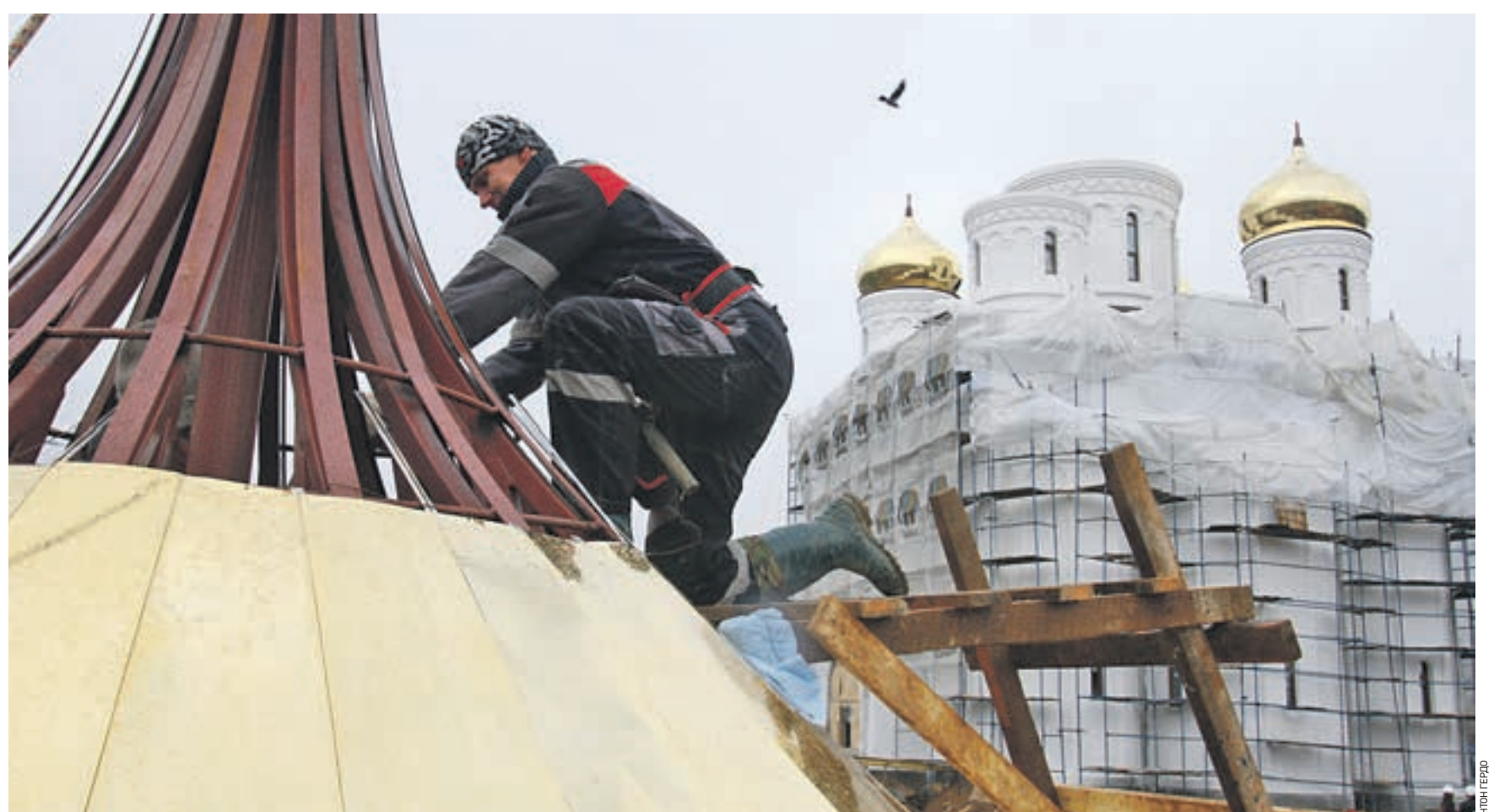
8 ноября 2012 года. Строительство еще одного храма по «Программе-200» в микрорайоне Солнцево: работы на куполах ведутся по той же технологии, которая применялась при постройке храма Христа Спасителя
