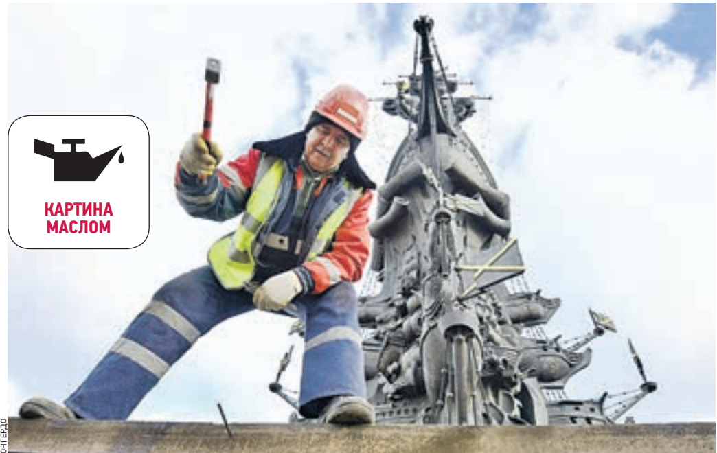
Вчера. Искусственный островок между Москвой-рекой и Обводным каналом. Рабочий Гормоста Сергей Жаренков с недюжинной силой вбивает 25-сантиметровый гвоздь в брусья нового пола
