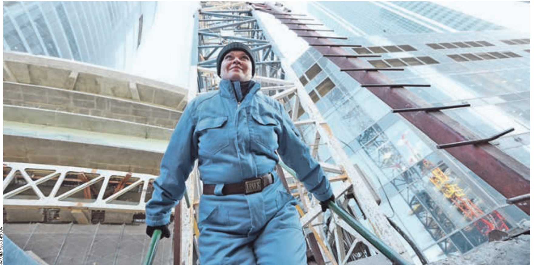
Вчера 10:45 Машинист башенного крана Галина Кузнецова уже 33 года строит дома. Рассказывает, что иногда друзья и знакомые звонят ей, чтобы узнать, где на столичных дорогах образовались заторы. «Мне сверху весь город видно, получше навигатора подскажу», — уверяет Галина
