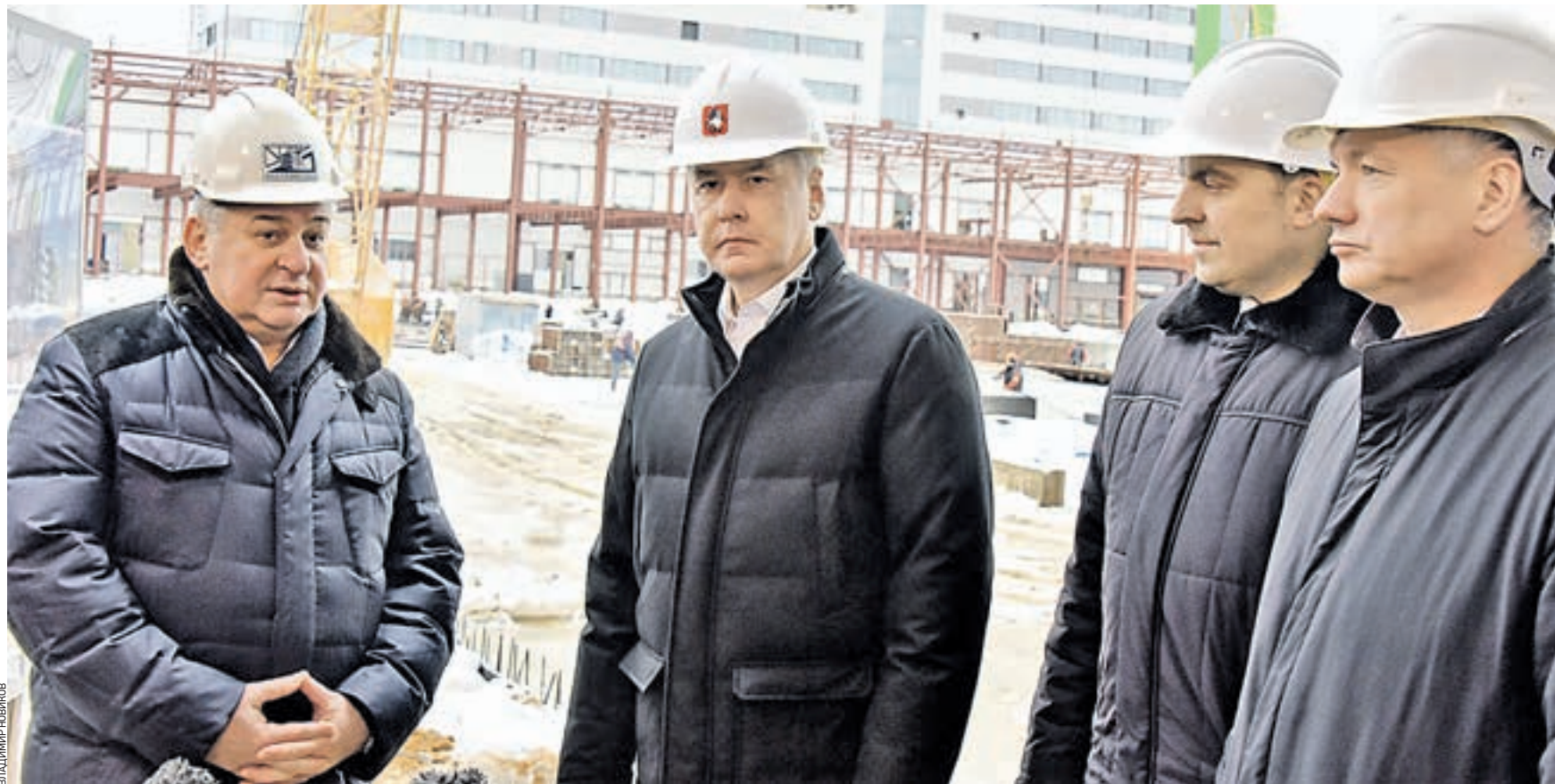
Вчера 11:27 Слева направо: генеральный директор компании-подрядчика Олег Лянг, мэр Москвы Сергей Собянин, начальник Московского метрополитена Дмитрий Пегов и заммэра Москвы по вопросам градостроительной политики и строительства Марат Хуснуллин осматривают строящееся на севере столицы электродепо «Верхние Лихоборы»
