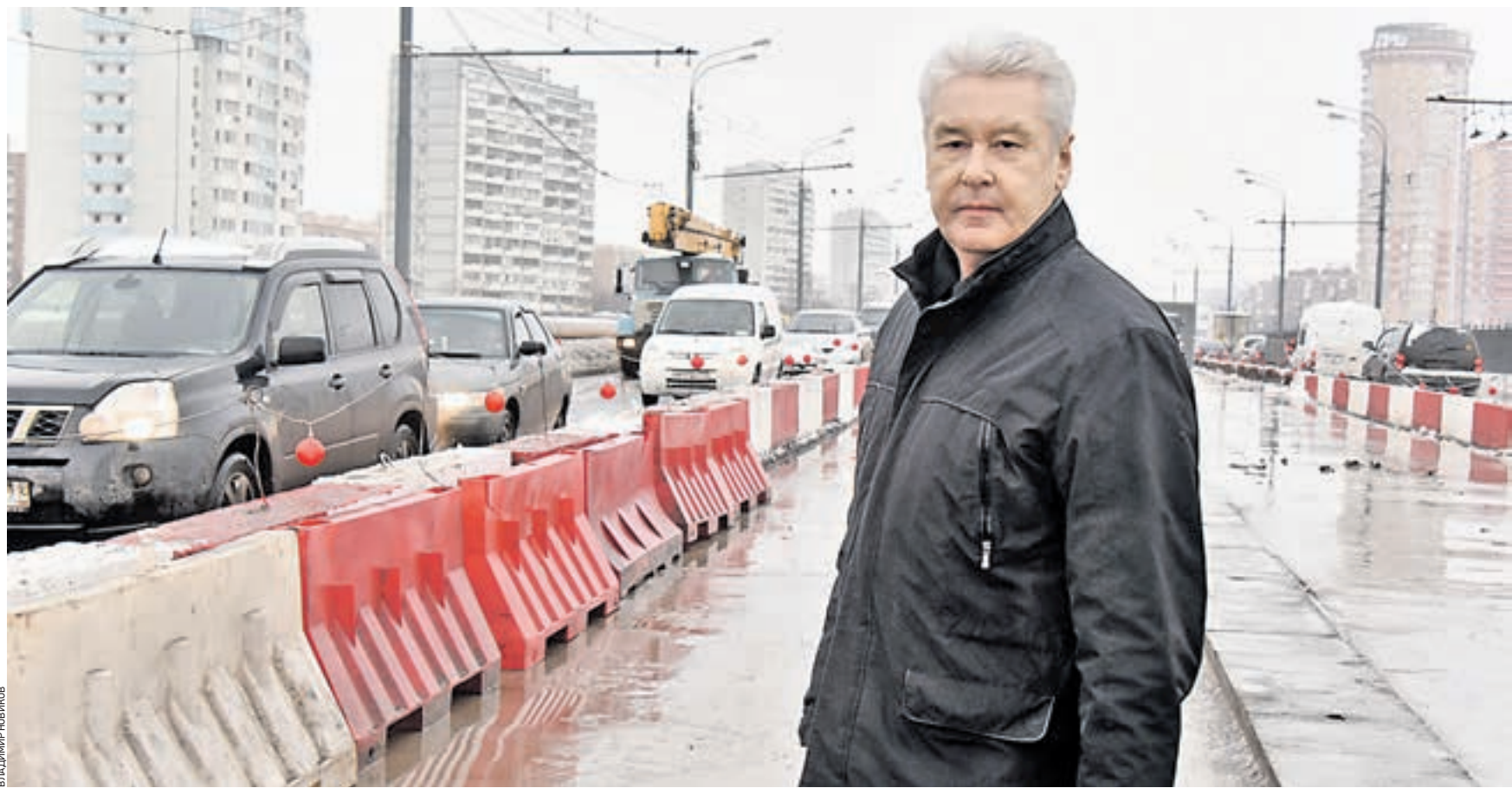
Вчера 11:17 Мэр Москвы Сергей Собянин осматривал ход реконструкции Нагатинского моста. Его возвели в 1969 году, и теперь одно из самых сложных сооружений Москвы требует ремонта. Без перекрытия автомобильного движения рабочие обещают завершить реконструкцию к 2017 году
