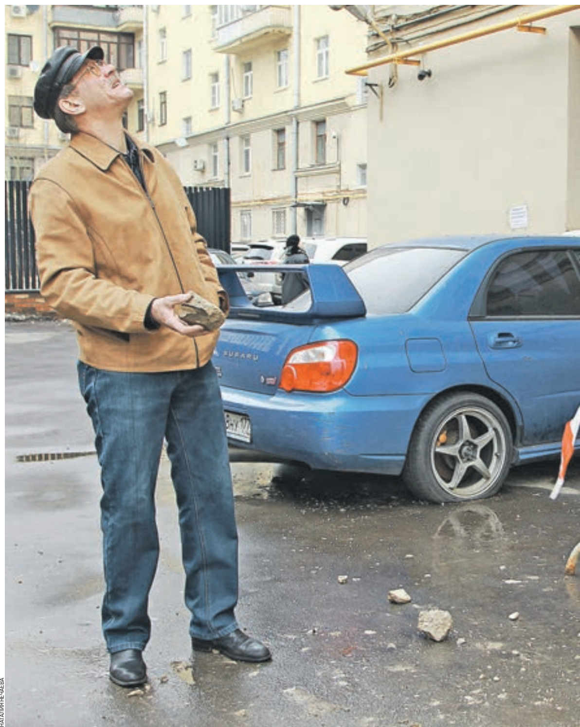
12:26 Космодамианская набережная, 32–34. Муниципальный депутат Алексей Елистратов изучает место обрушения фасада
