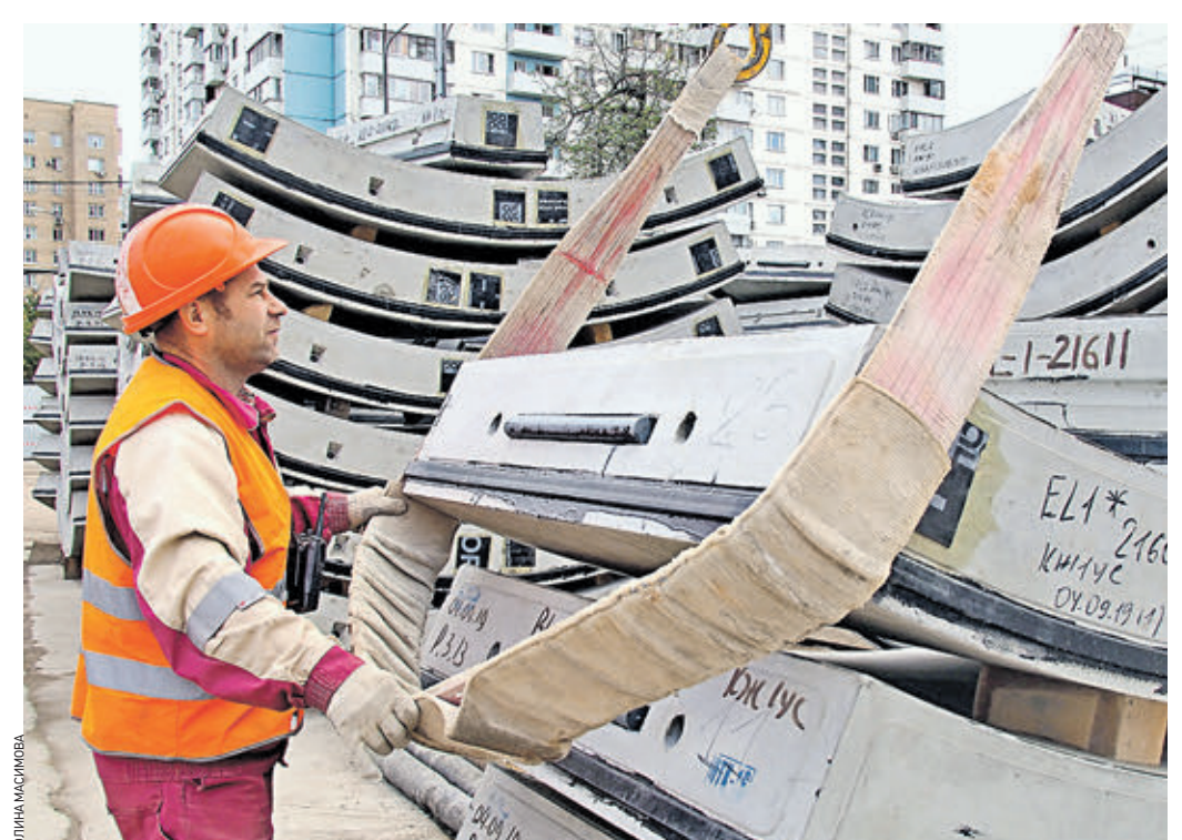
14 сентября 10:23 Проходчик Владимир Кархагин крепит стропы к тубингу на площадке строящейся станции «Стромынка» Большой кольцевой линии метро
