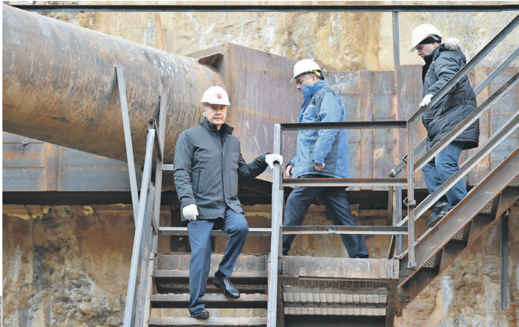
Вчера 11:00 Мэр Москвы Сергей Собянин, заместитель мэра Москвы по вопросам градостроительной политики и строительства Марат Хуснуллин и председатель совета директоров компании-подрядчика Владимир Петрук (на фото слева направо) на строящейся станции «Зюзино» Большой кольцевой линии метро
