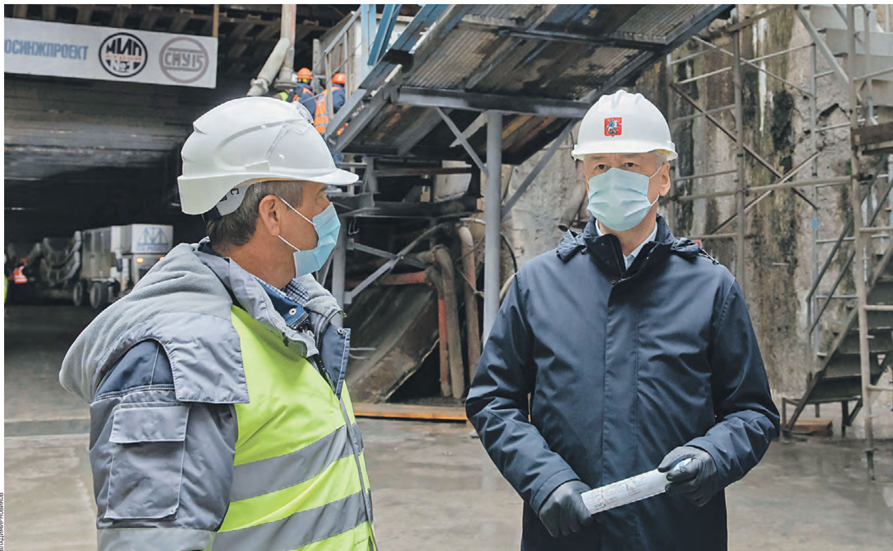
23 октября 13:07 Мэр Москвы Сергей Собянин (справа) и заместитель генерального директора по строительству объектов метрополитена Мосинжпроект Валерий Кивлюк осмотрели стройку станции «Текстильщики» Большой кольцевой линии метро. Сейчас она готова на 50 процентов
