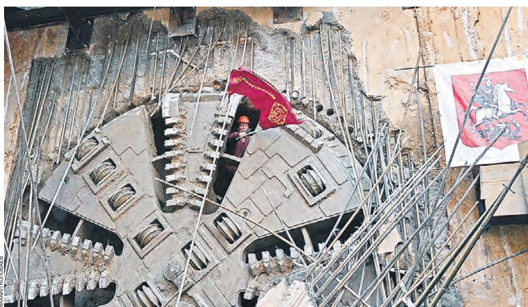
22 ноября 12:10 Выход тоннелепроходческого щита на станции «Физтех» Люблинско-Дмитровской линии метро
