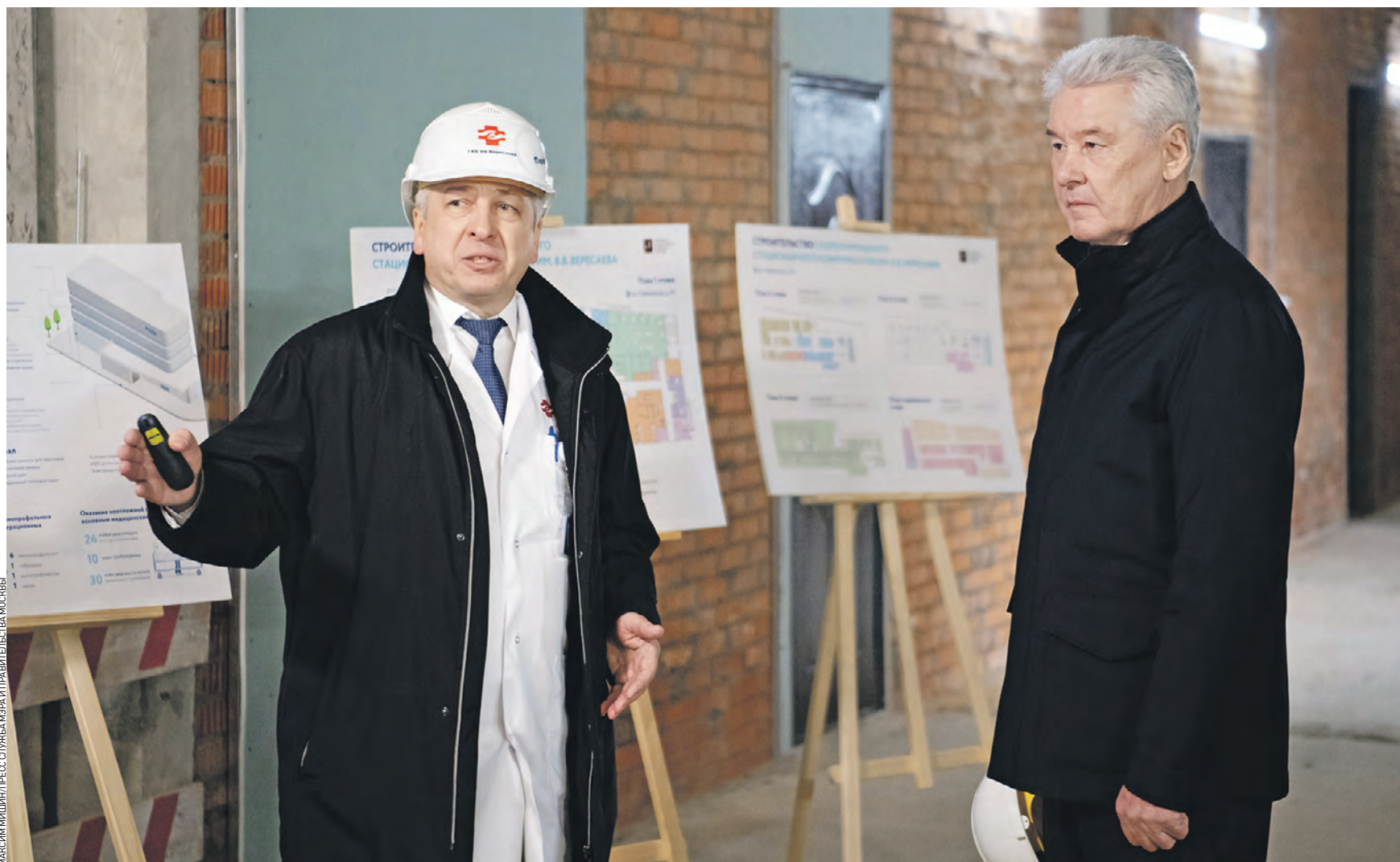
Вчера 11:10 Мэр Москвы Сергей Собянин (справа) и главный врач Городской клинической больницы имени Вересаева Игорь Парфенов осматривают ход строительства стационара. Новый корпус больницы будет рассчитан на прием до 200 неотложных пациентов в день
