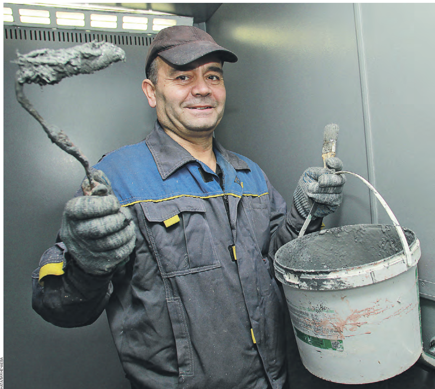
6 декабря 2018 года. Маляр ГБУ «Жилищник» Бахтияр Хамроев красит стены лифта в доме по Волховскому переулку столицы. Жильцы дома вполне могут проследить за качеством выполнения работ
