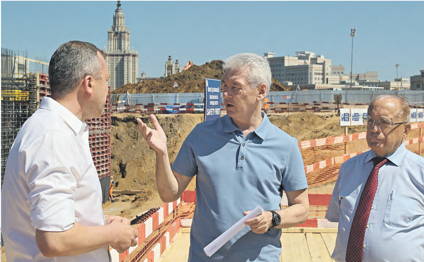
12 июля 2021 года 11:42 Мэр Москвы Сергей Собянин (в центре) и ректор МГУ им. Ломоносова Виктор Садовничий (справа) во время посещения строительства Инновационного научно-технологического центра «Воробьевы горы»
