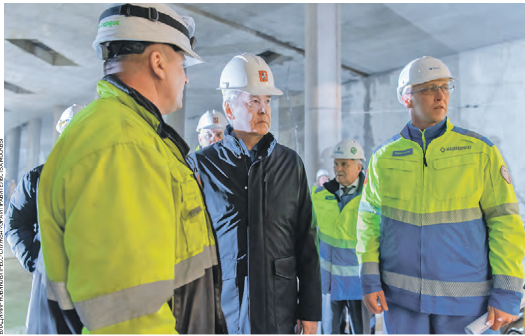
Вчера 13:15 Мэр Москвы Сергей Собянин (в центре), замглавы Департамента строительства Сергей Сущенко (слева) и заместитель гендиректора компании-подрядчика Евгений Федорченко осматривали ход строительства станции «Генерала Тюленева»
