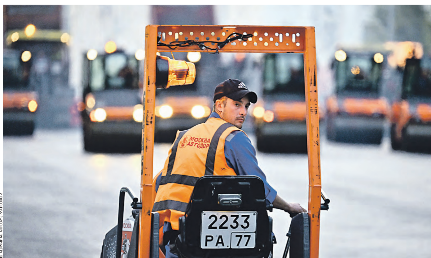
24 августа. Ведутся работы по замене асфальта на Тверской улице. Инновационные битумные материалы делают дорожное покрытие более устойчивым к деформации и разрушению, образованию трещин и колеи
