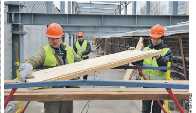
2 апреля 2015 года. Станция метро «Технопарк» возводится на уже действующей линии подземки, работы здесь идут круглые сутки
