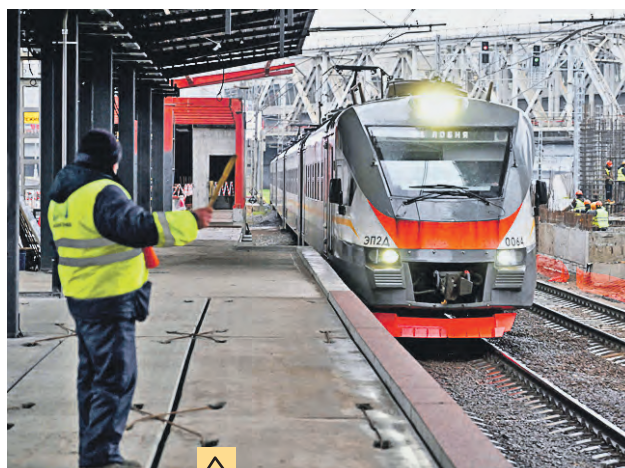
Строительство городского вокзала «Москва-Сити» МЦД-1
