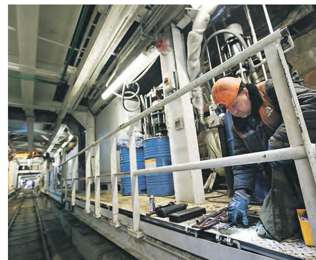
10 марта 2017 года. Проходка тоннеля от станции «Косино» до «Улицы Дмитриевского»
