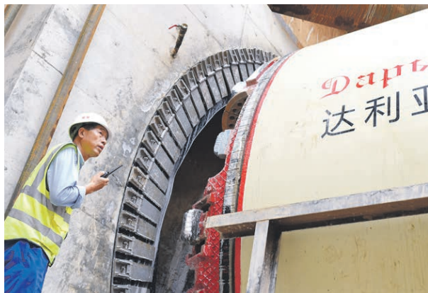
15 августа 2018 года. Запуск тоннелепроходческого щита от станции «Аминьевский проспект»
