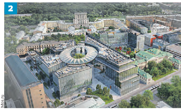
Проектное решение нового кампуса МГТУ имени Баумана (1) и как он будет выглядеть с высоты (2)
