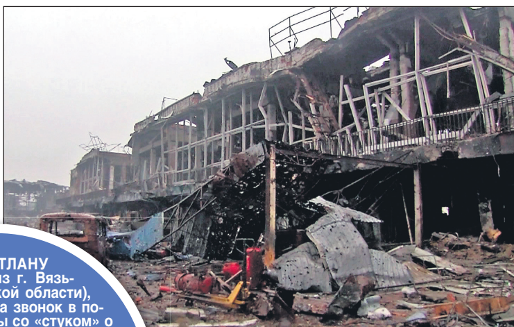
Донецкий аэропорт полностью разрушен
